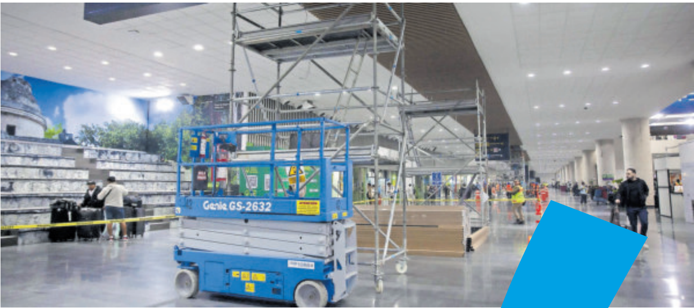
Rumbo al Mundial se hacen obras de remodelación en la terminal aérea.
