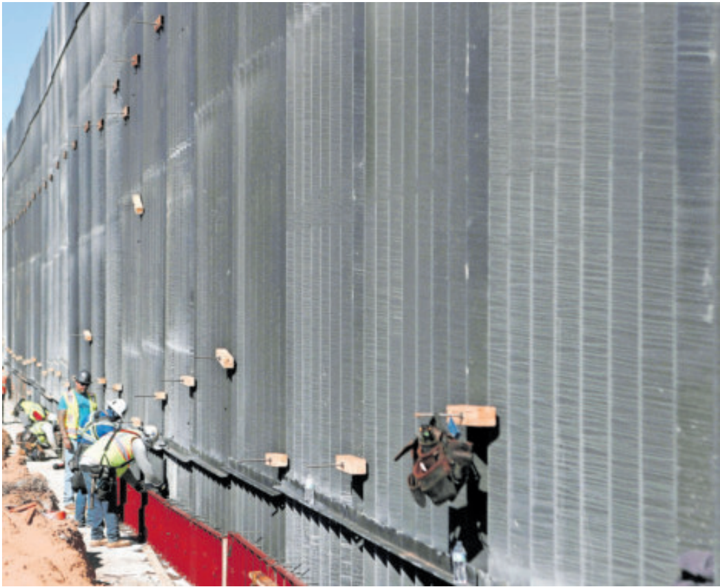
Obreros estadounidenses construyen un muro fronterizo entre El Paso y Ciudad Juárez.
