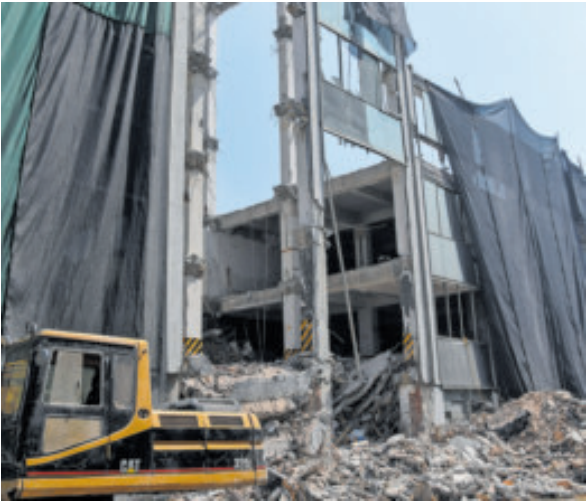
Inmueble en demolición en San Antonio Abad.
