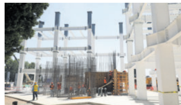
Apoyará con obras de infraestructura.
