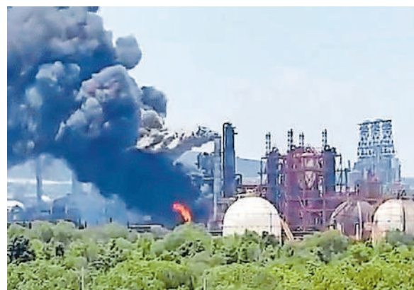
Se registró un incendio tras explosión en el lugar.
