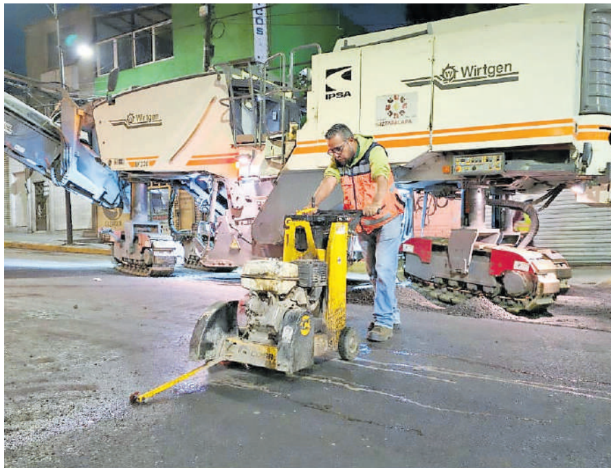
Los trabajos se realizan durante la noche.
