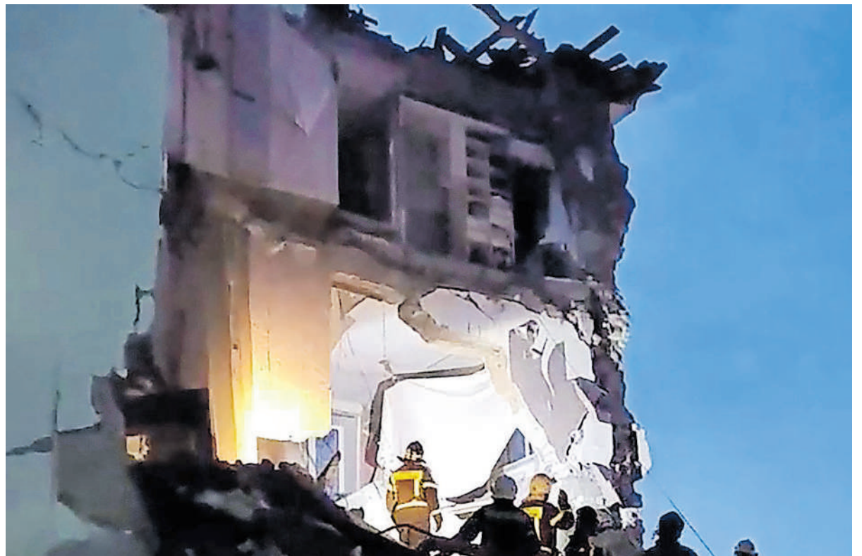
Un edificio departamental fue dañado tras un ataque ucraniano con drones en Syzran, Rusia.
