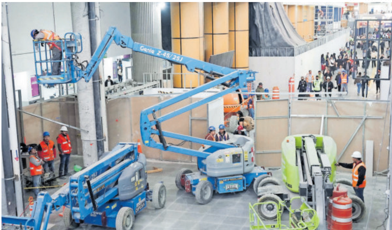
La inversión en la maquinaria y equipo se contrajo, según el Inegi.
