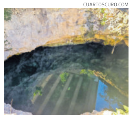
Activistas han acusado corrosión en las columnas del paso del tren.
