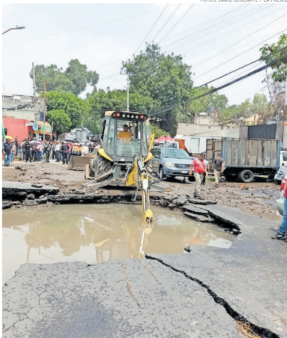
Equipo especial llegó para reparar la tubería.
