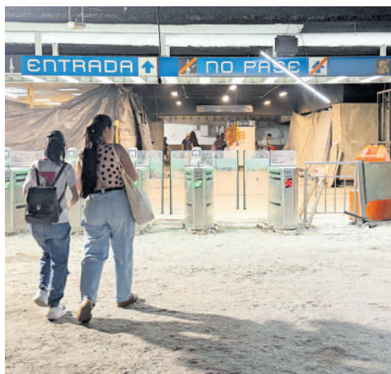
Así lucen las obras de la L2.
